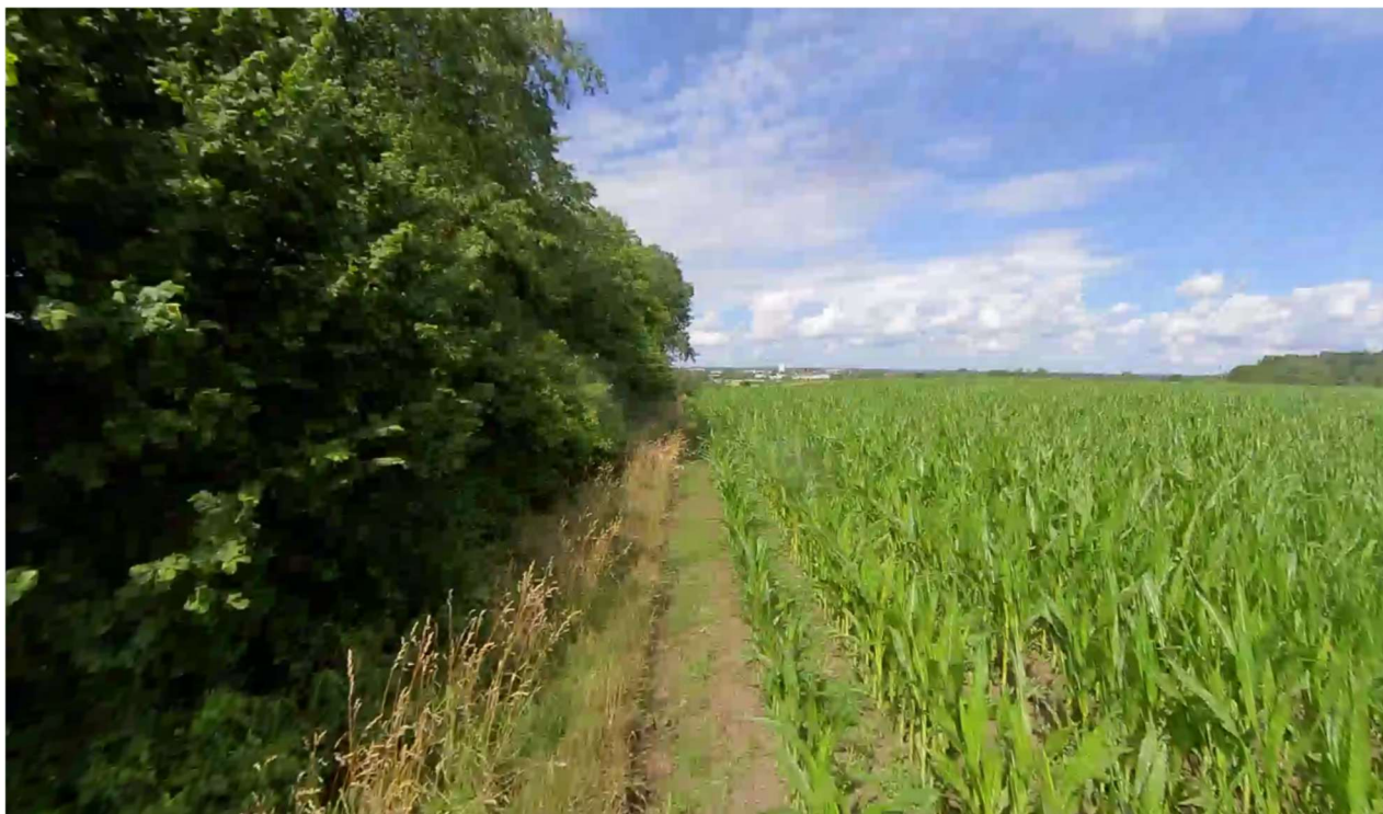
Blick nach Westen, ca. Mitte Leitungsverlegung
